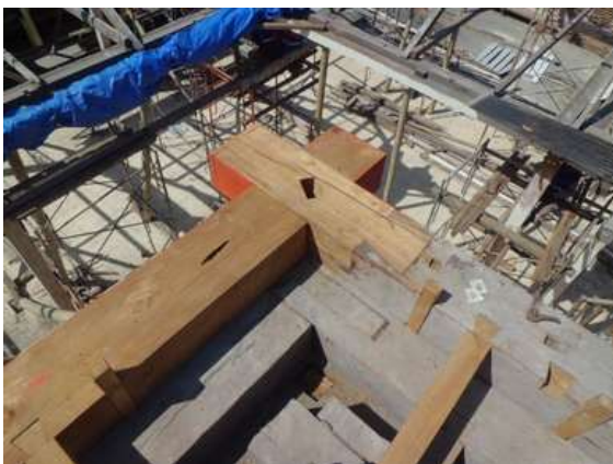
Gambar 5. Gandamaru yang terpasang pada balok tumpangsari
