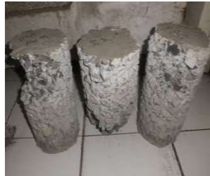
Gambar 6. Kerusakan beton dengan split Merapi faktor air semen 0.4
